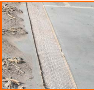
Beschichtungen entfernen / Removal of coatings
