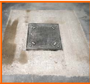
Fräsen im Quadrat / Square milling
