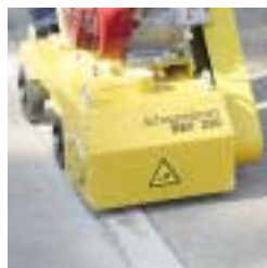
Entfernung von Markierungen Removal of line markings
