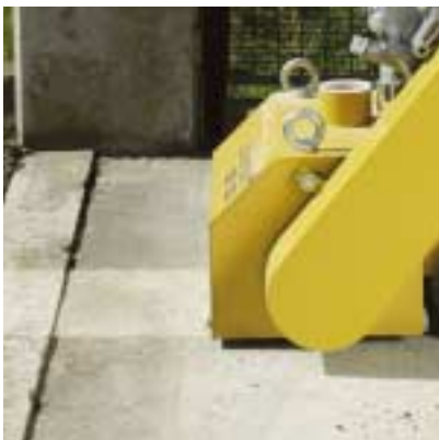
Abfräsen von Bodenebenheiten Levelling of floor misalignments
