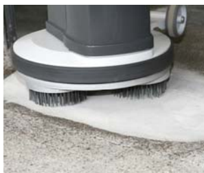
Usuwanie warstw / Scarifying
